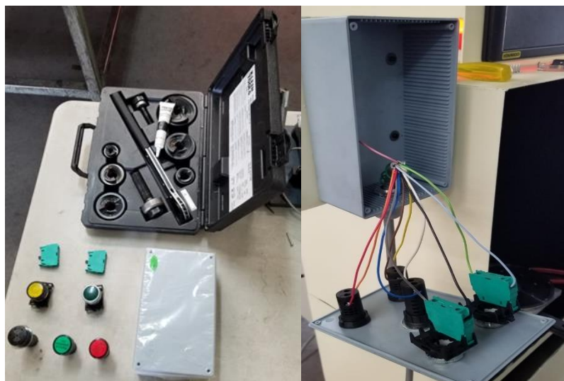
Figura 26. Instalación de botonera en tablero.
